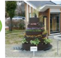
ロハス花壇：自然の浄化機能を活かしたエネルギー不要の排水処理システムを設置した花壇(参考写真：日大HPより)
