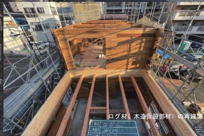
ログ材（木造仮設部材）の保管
